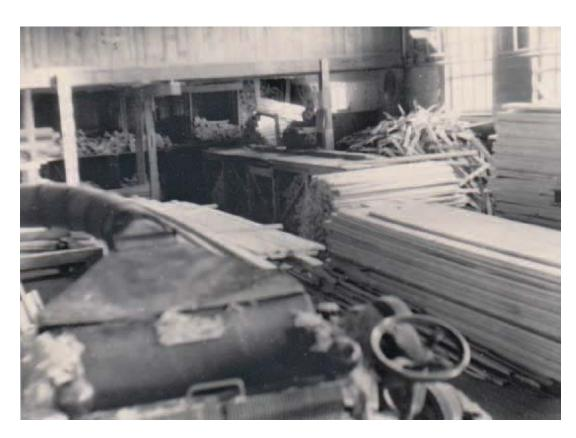
1964 Nut- und Spundmaschine zur Herstellung von Rauspund und Hobelmaschine
