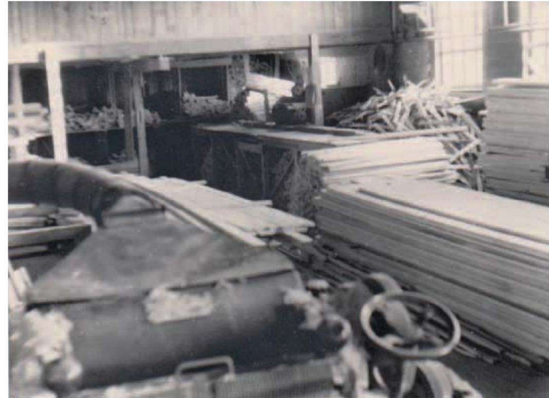
1964 Nut- und Spundmaschine zur Herstellung von Rauspund und Hobelmaschine
