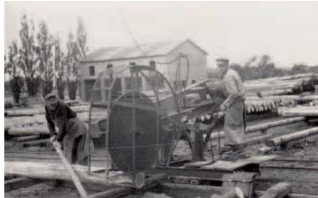
Vorarbeiter Steglich (re.) und seine „Klara“, einer Kreissäge zum Ablängen der Rundholzstämmе
